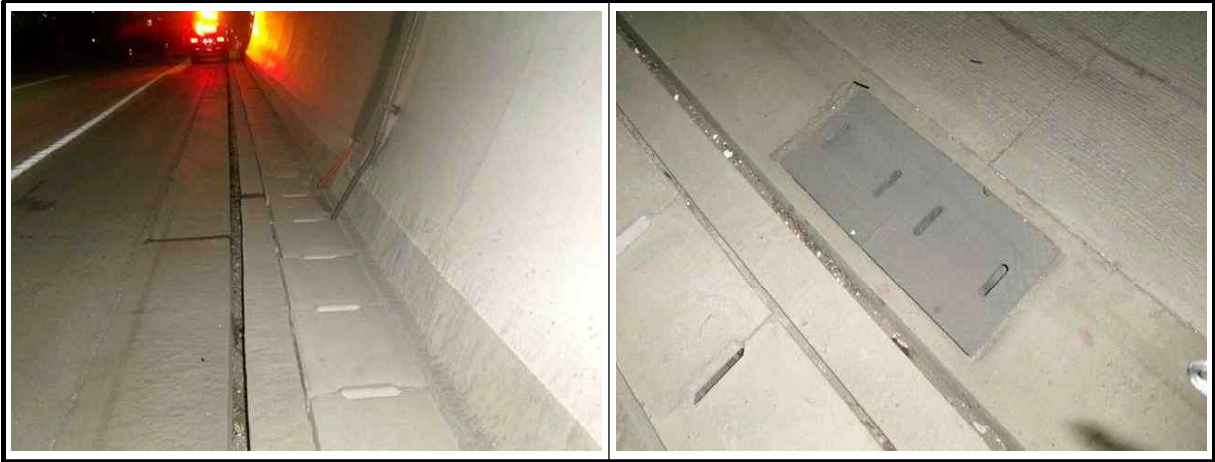
【사진 4.3.8】 공동구 및 배수시설 전경
