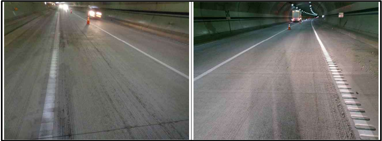
【사진 4.3.23】 포장부 전경
