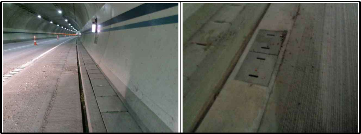
【사진 4.3.21】 공동구 및 배수시설 전경
