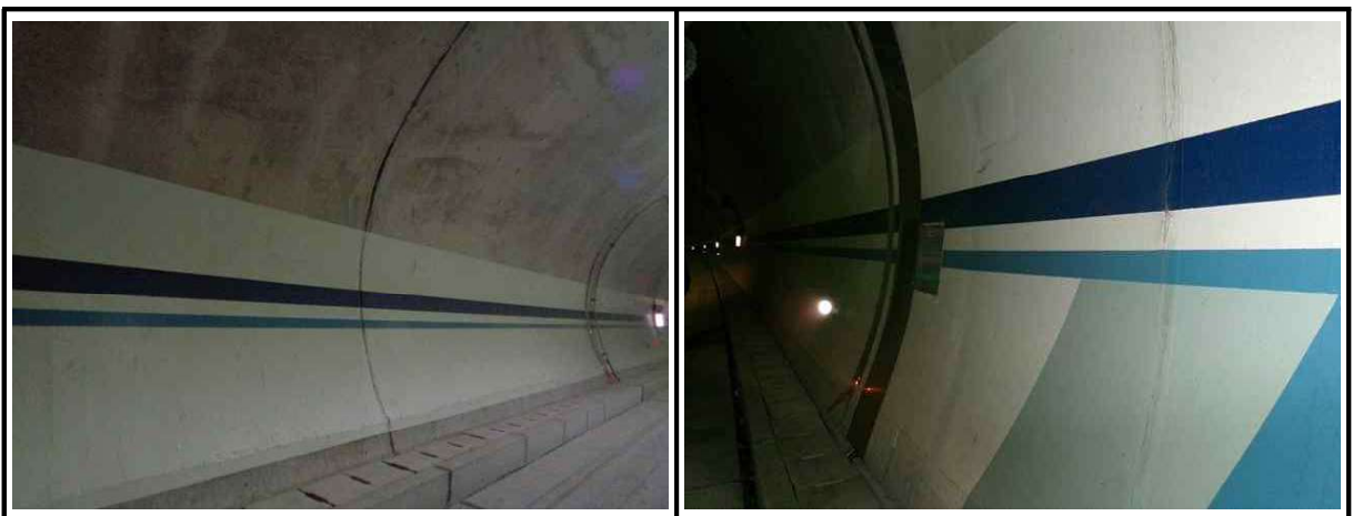
【사진 4.3.3】 라이닝 측벽부 전경
