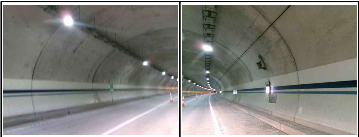
【사진 4.3.16】 라이닝 측벽부 전경
