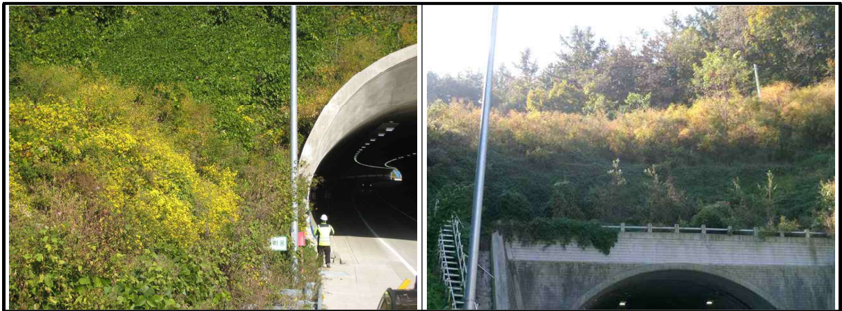
【사진 4.3.20】 사면 전경
