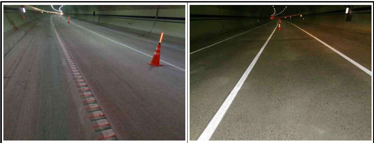
【사진 4.3.10】 포장부 전경
