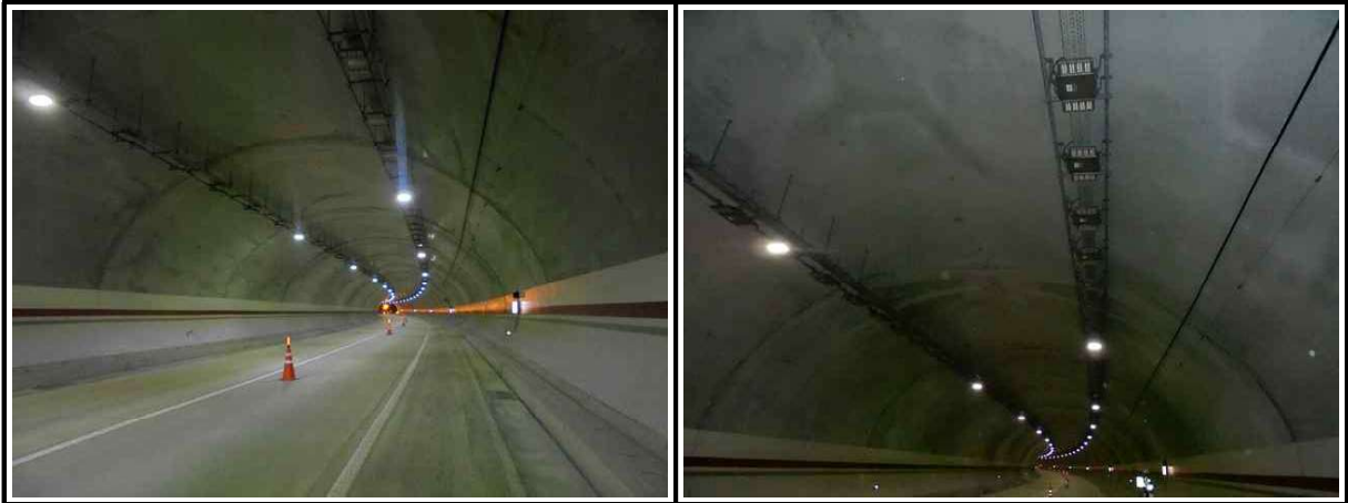
【사진 4.3.14】 라이닝 천단부 전경
