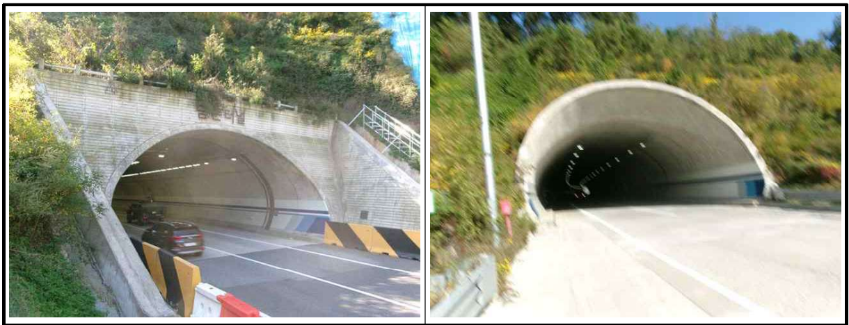
【사진 4.3.5】 갭문 전경
