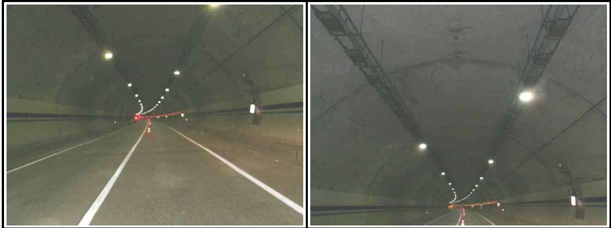
【사진 4.3.1】 라이닝 천단부 전경
