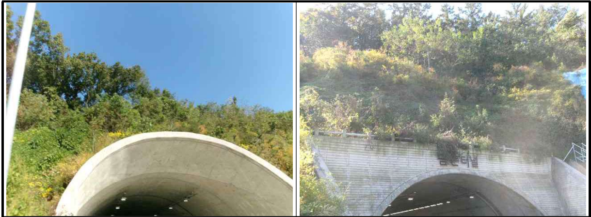
【사진 4.3.7】 사면 전경
