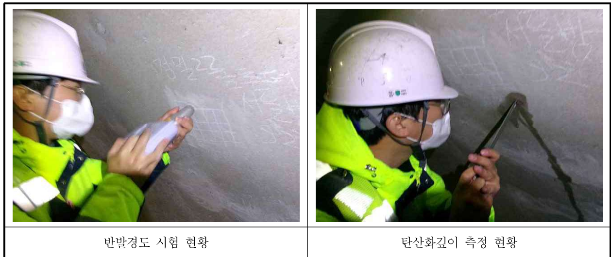
【사진 4.4.1】 콘크리트 내구성조사 현황
